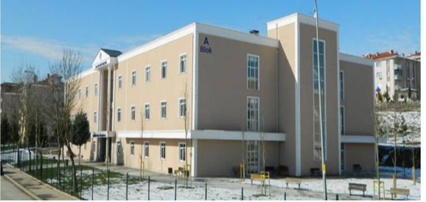
Sakarya Meslek Yüksekokulu Binası
