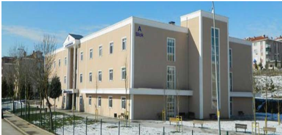
Sakarya Meslek Yüksekokulu Binası
