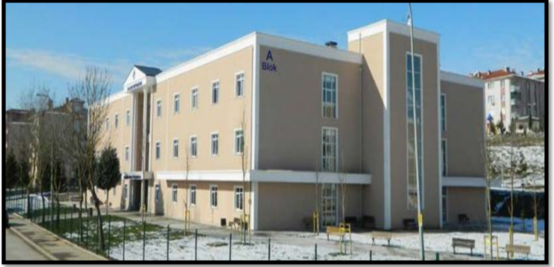
Şekil 1: Sakarya Meslek Yüksekokulu Binası
