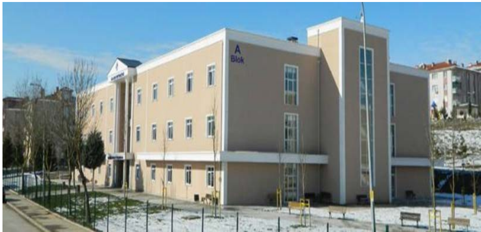
Sakarya Meslek Yüksekokulu Binası
