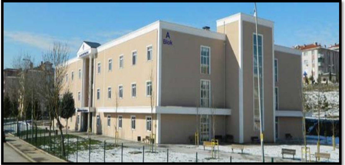
Şekil 1: Sakarya Meslek Yüksekokulu Binası
